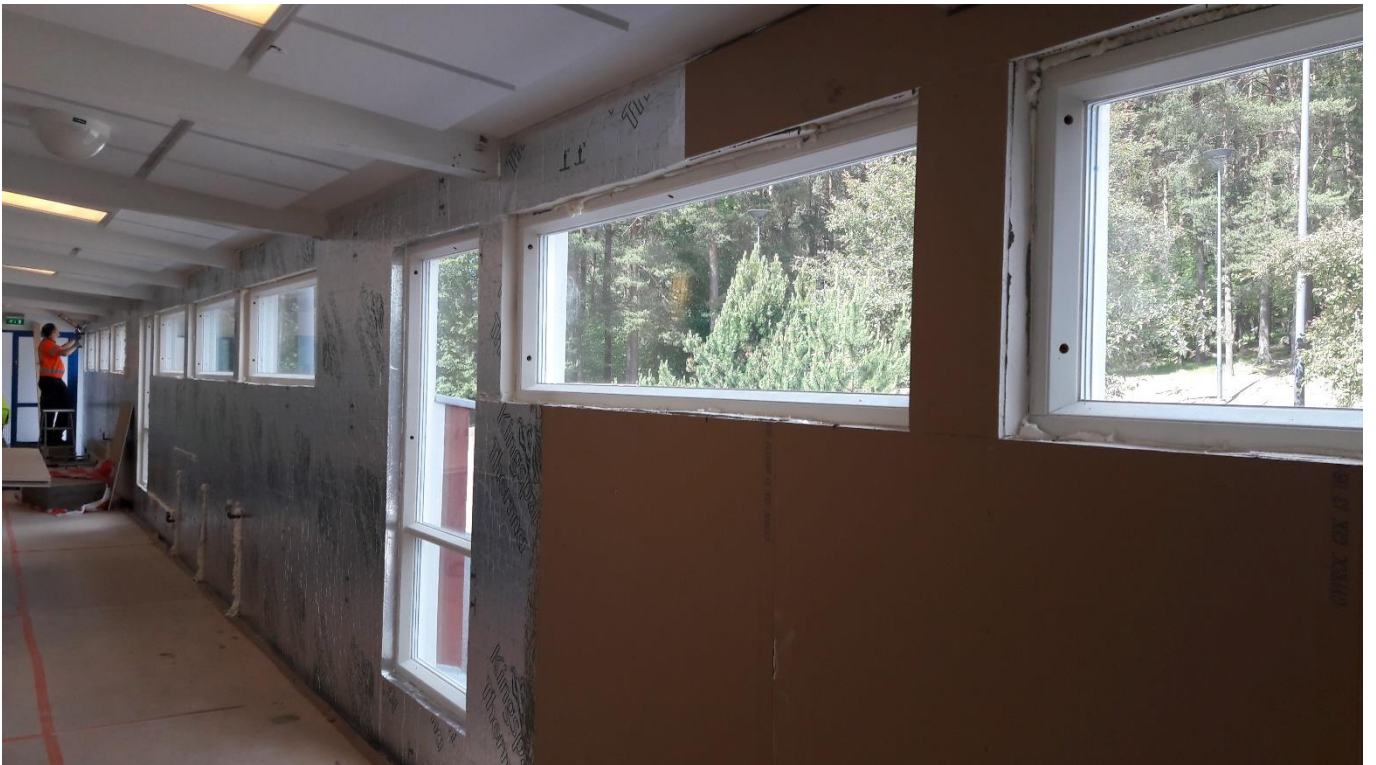
Käytäväseinällä asennettuna uretaanilevy.
