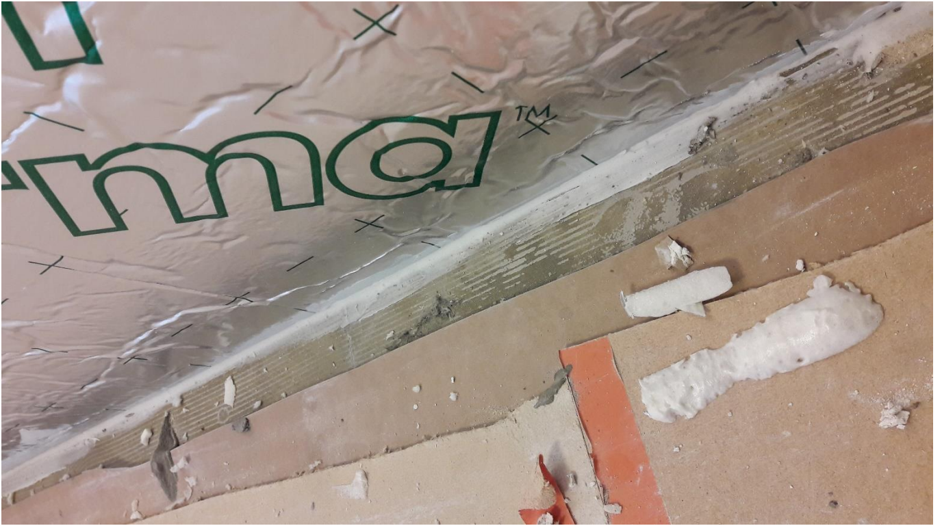
Lattiaraja kitattiin tiivistysmassalla, jonka jälkeen uretaanilevyn päälle asennettiin kipsilevy, johon nostettiin uusittu osa lattiamattoa.
