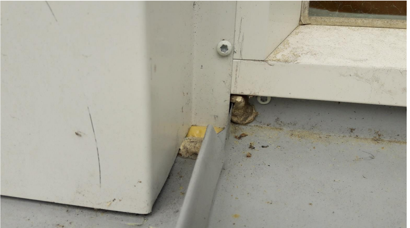
Käytävä- ja luokkaseinien ikkunapellitykset uusittiin.
