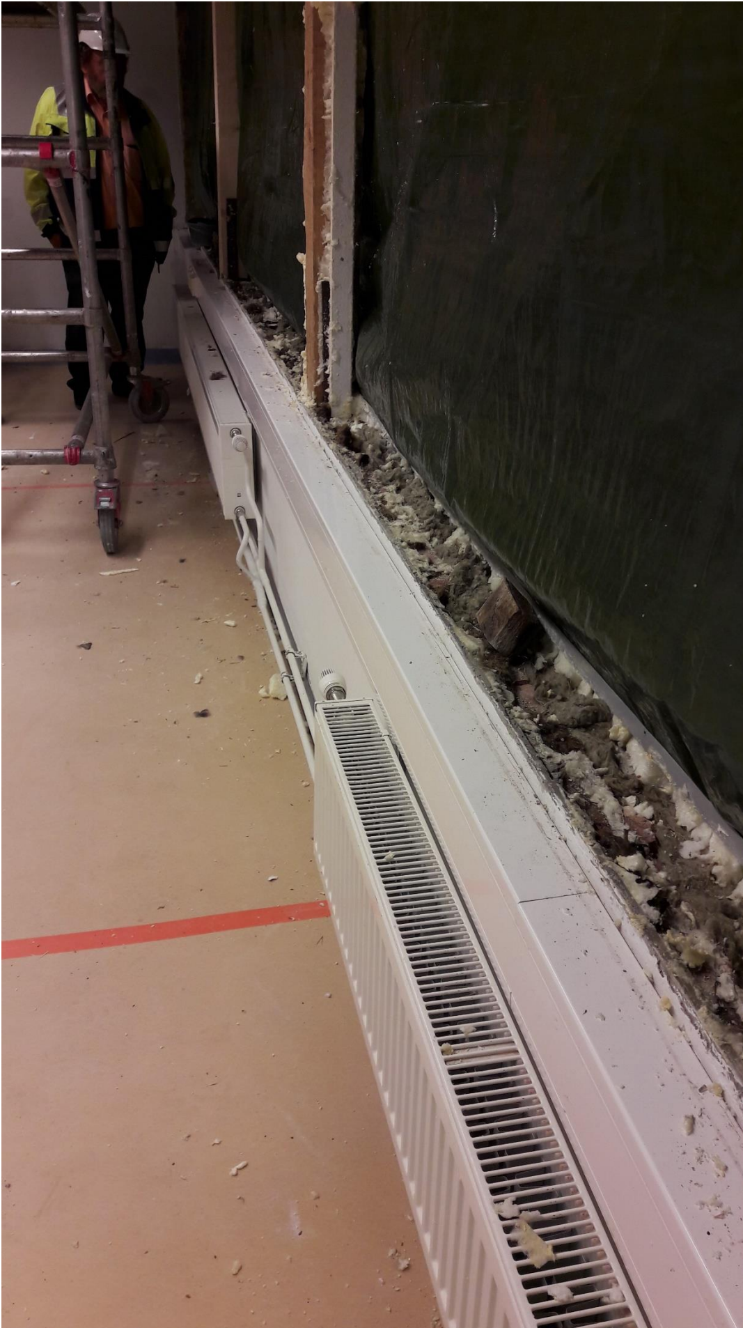
Luokkahuoneen ikkunoiden poiston yhteydessä poistettiin vanhat uretaanit sekä villat.
