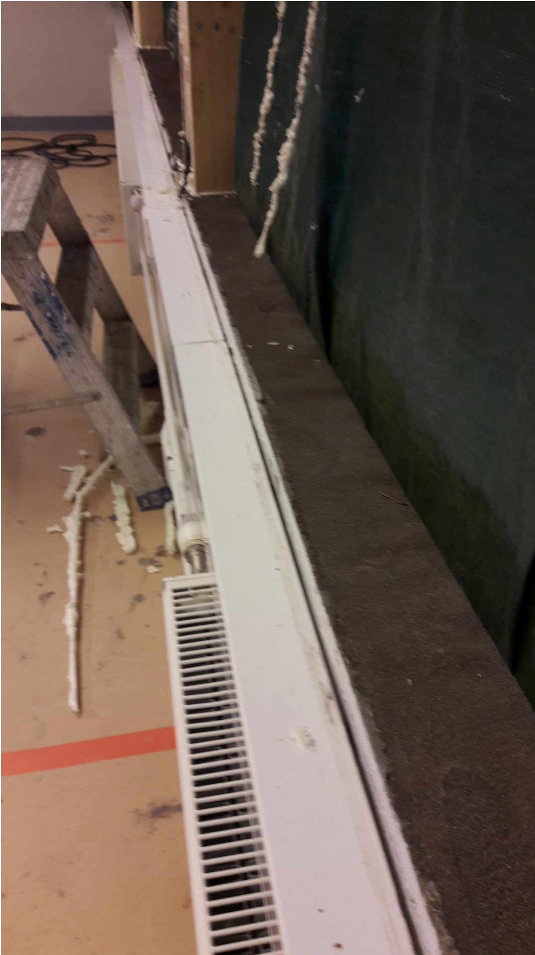
Elementin monttu valettiin.
