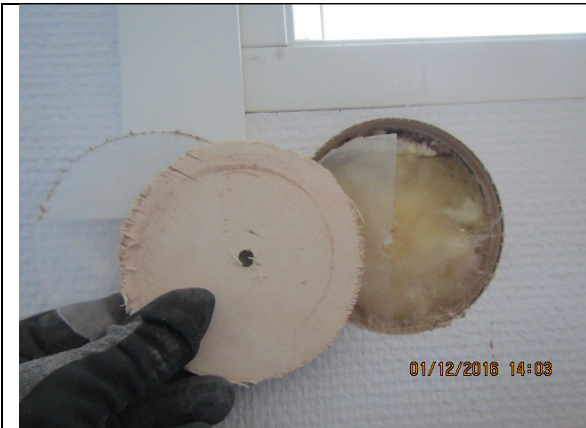
Kuva 5. Pääskyvuoren koulun 1. krs käytävän sisäverhouslevy oli vaneria. Rakenteen höyrynsulku on asianmukainen.
