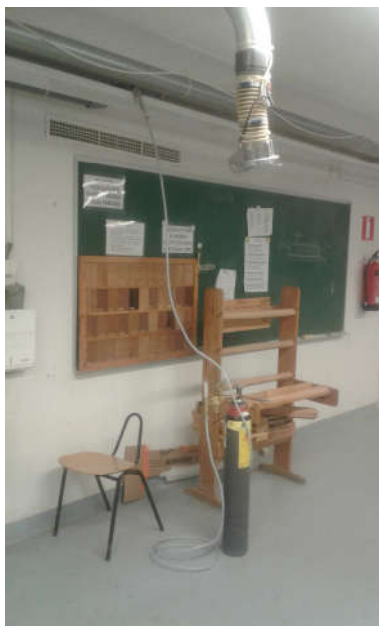
Kuva 1. Merkkikaasua laskettiin puutyöluokkien, käytävän ja siivouskomeron välipohjarakenteen välitilaan
