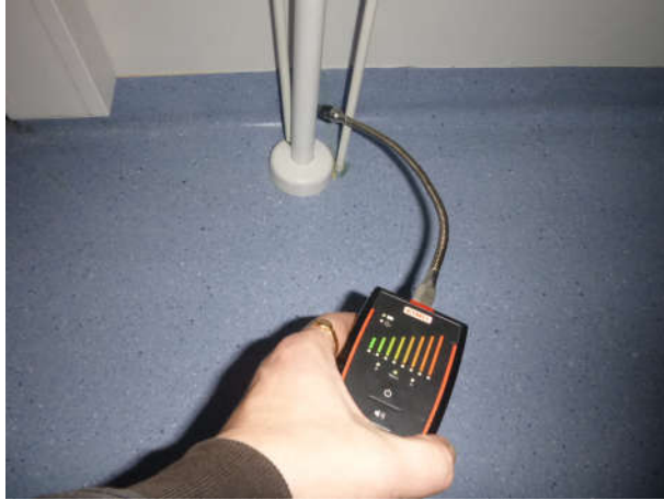
Kuva 2. Luokkahuoneen putkiläpiviennin tarkastusmittaus
